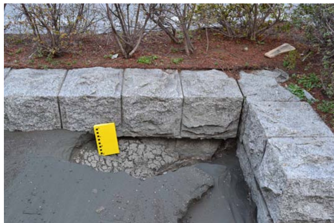
8 JR 海浜幕張駅前歩道の植込み脇の噴砂口 植栽柵などの構造物の脇から噴砂が起こり、大量の 暗灰色の泥状の細砂が地表に堆積した。 2011.3.13
