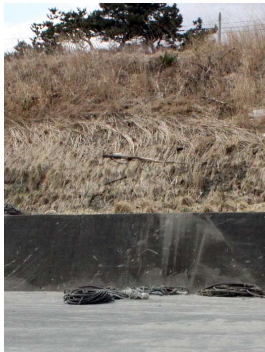
写真8. 角浜漁港の津波の痕跡 (2011/4/3)
