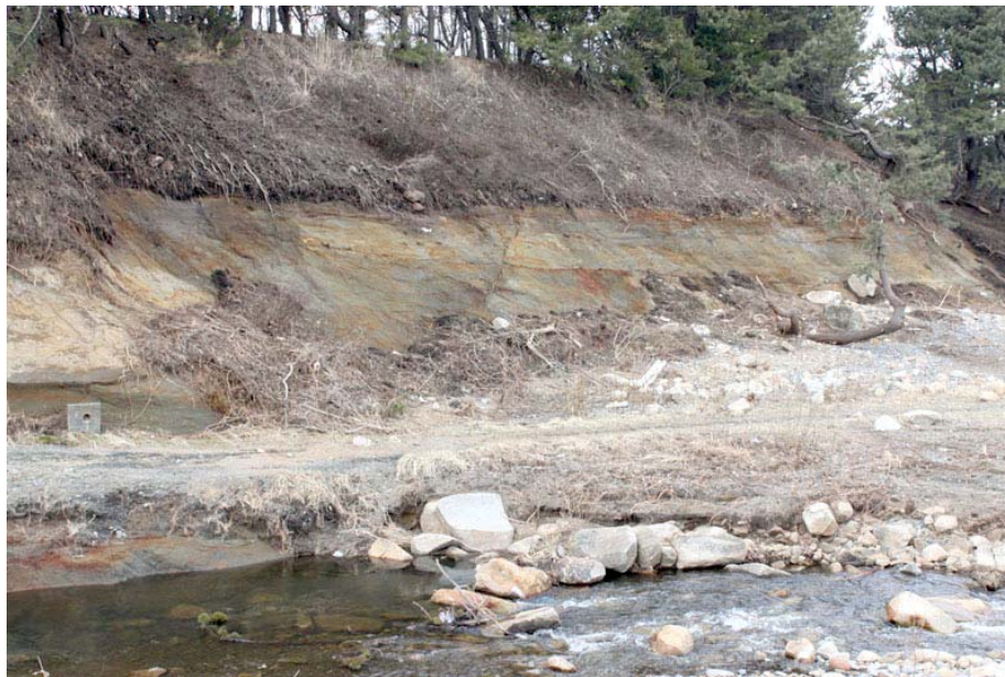
写真5. 和座川河口付近の津波の痕跡 (2011/4/3)
